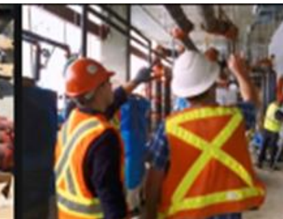
Unterstützung auf der Baustelle
